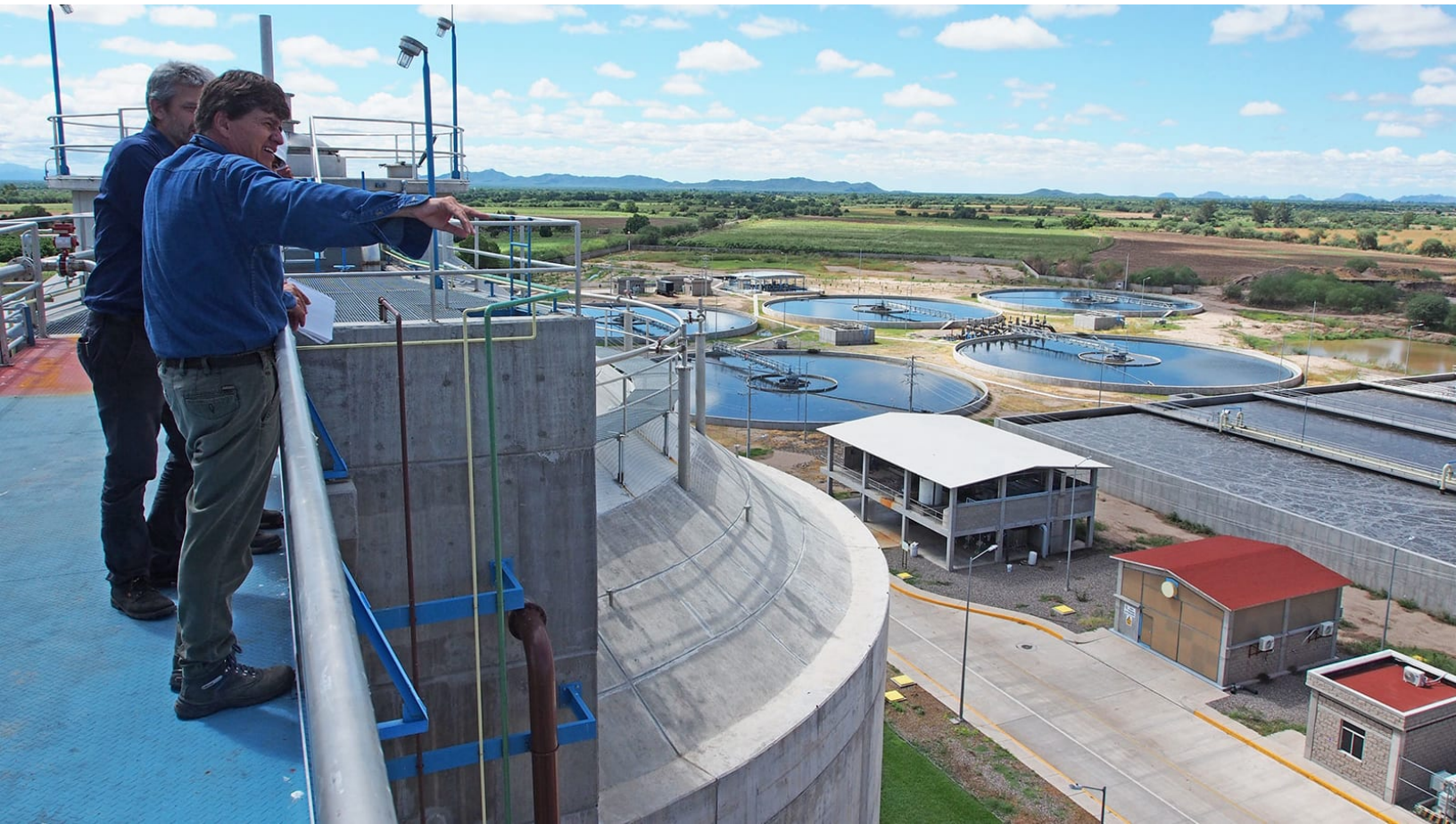
Foto: Energistyrelsen. Biogasanlæg i Mexico.
