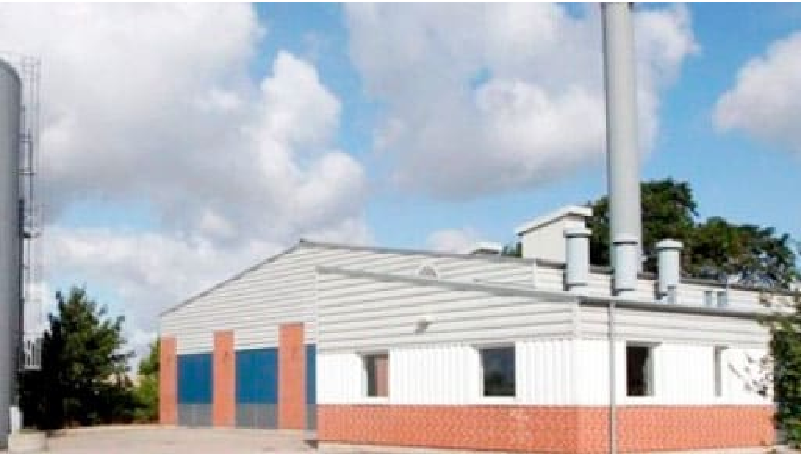
Foto: Veddam-Skelund-Visborg Kraftvarmeværk
